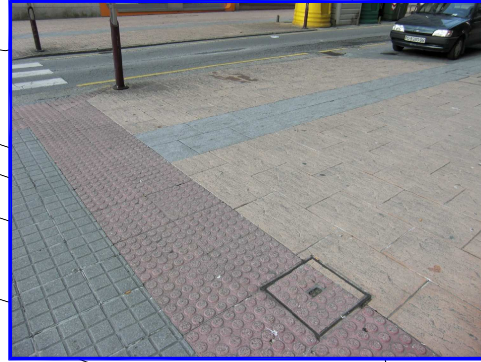
PAVIMENTO EXISTENTE RUA AUGUSTO GONZÁLEZ BESADA
