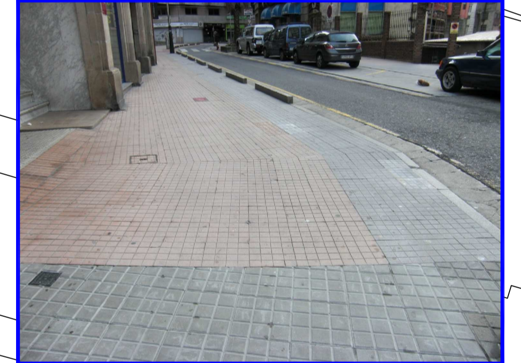
PAVIMENTO EXISTENTE RUA ANDRÉS MELLADO
