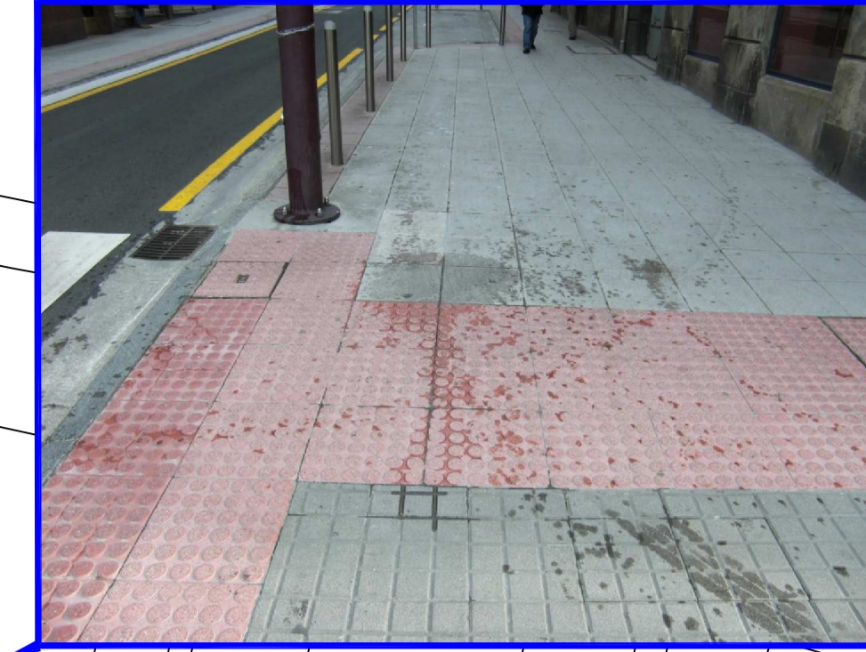
PAVIMENTO EXISTENTE RUA ANDRÉS MURUAIS
